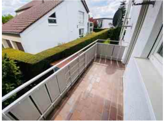
Kl. Balkone an allen Wohnungen
