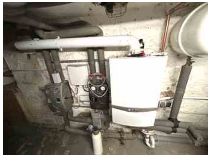
Vaillant Brennwert-Gastherme (2016)
